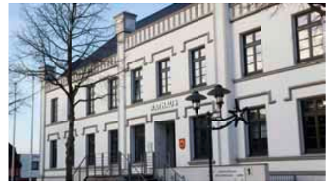
Grevesmühlens Rathaus heizt jetzt mit Fernwärme ...
