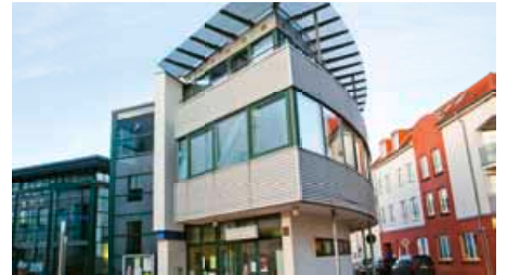
und auch die Stadtbibliothek bekommt bereits Wärme
